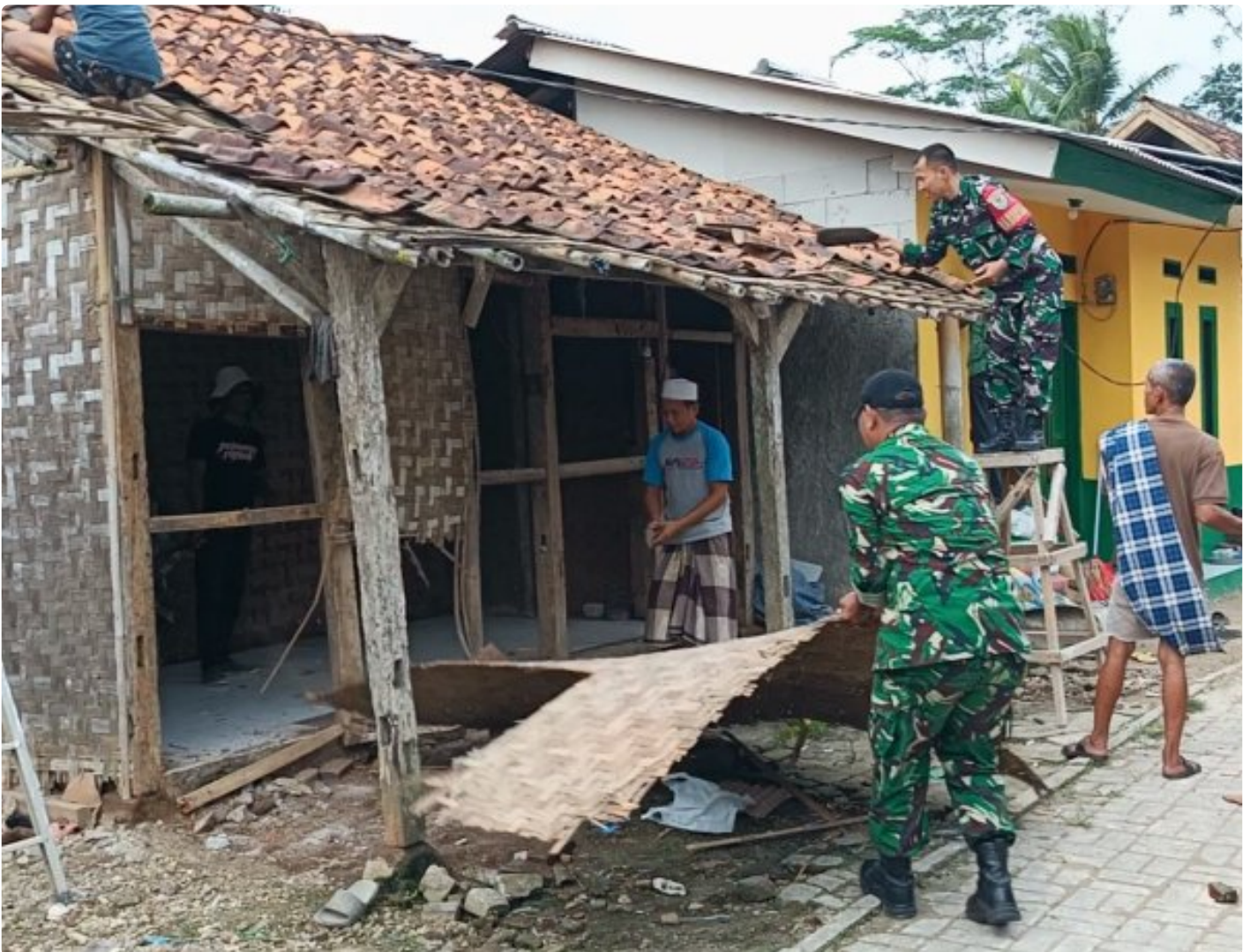
Pembongkaran Rumah Bapak Narmin
